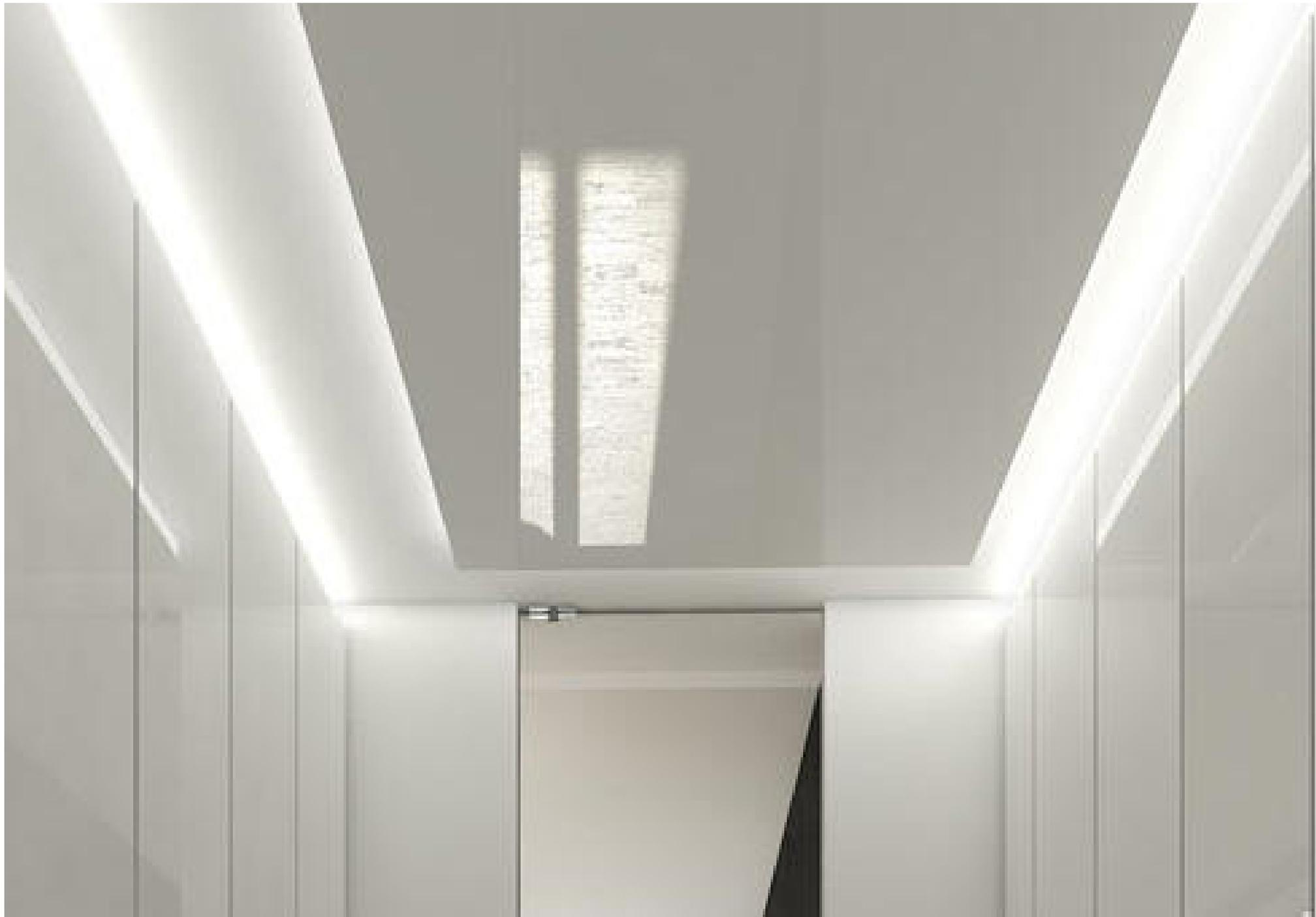
Foseado en falso techo para iluminación indirecta de tira de LED. Irá ubicado de forma perimetral en recibidor y distribuidor como se señala en el esquema.
